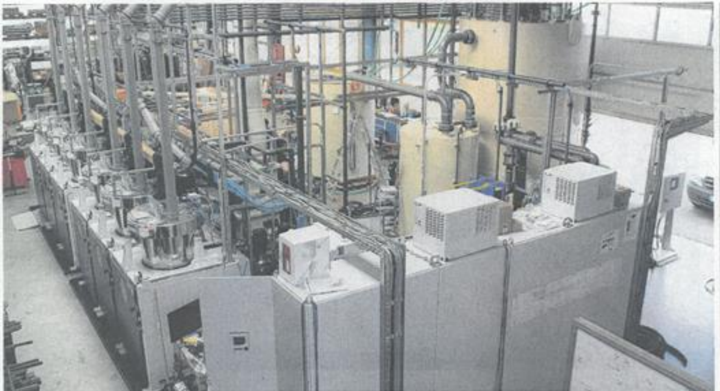
Die Firma Novoflow Umwelt- und Filtertechnik aus Rain hat einen Großauftrag für einen Automobilhersteller realisiert. Die Filteranlage für ein neues Motorenwerk in China wurde zunächst in Rain aufgebaut (Bild), bevor sie per Container an den Zielort verschifft wurde. Foto: David Häberlein
